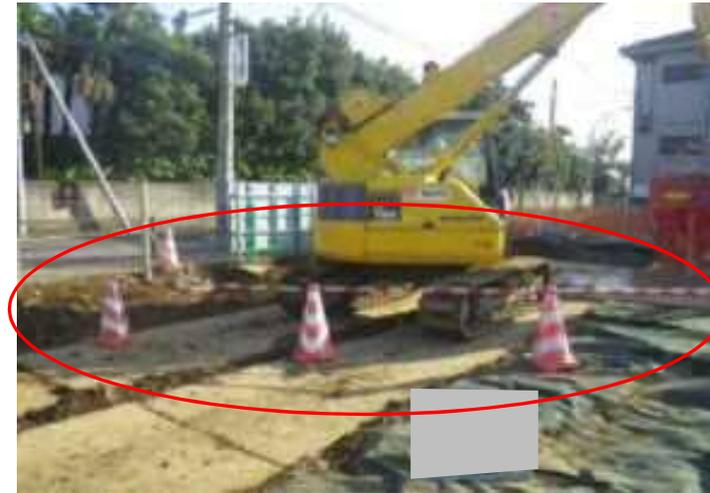
建設機械の稼働に関連した事故対策 重機の作業範囲を明示化
