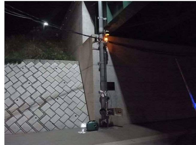
橋桁接触防止のためのレーザーバリア警報
