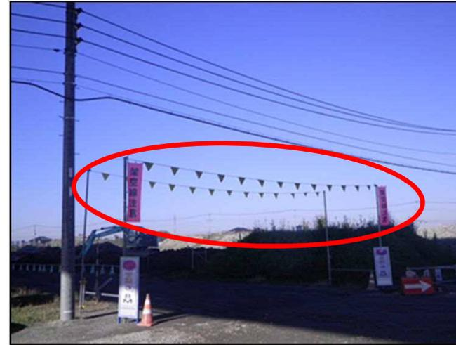
架空線対策 目印・高さ制限表示を設置
